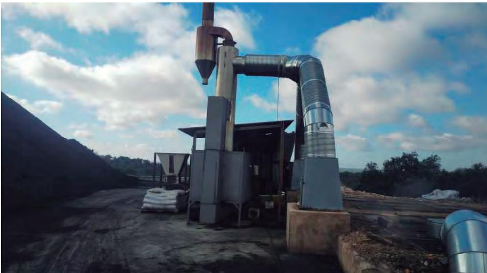
Imagen 3. Cámara de postcombustión en instalación de carbón vegetal.
